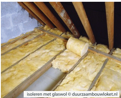
isoleren met glaswol © duurzaambouwloket.nl
