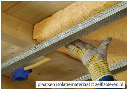
plaatsen isolatiemateriaal © zelfisoleren.nl
